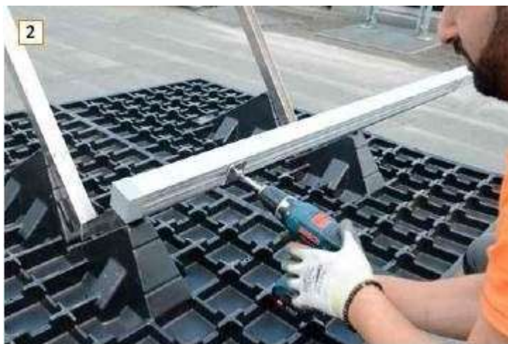
Verlegung SOLAR UK GD
