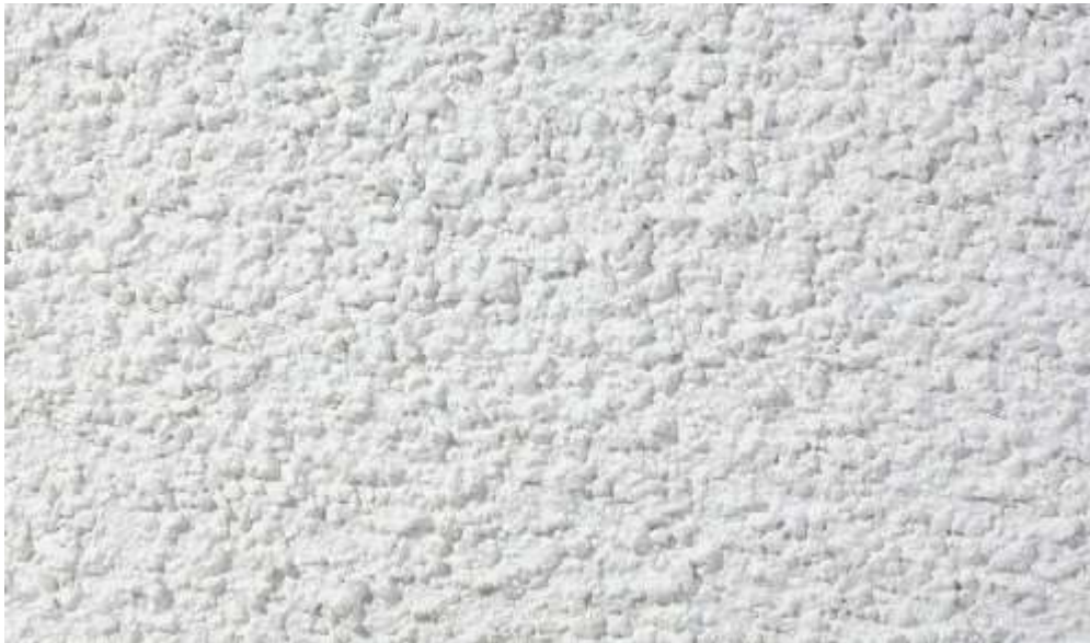
SYN_Fassadenputz grob gespritzt
