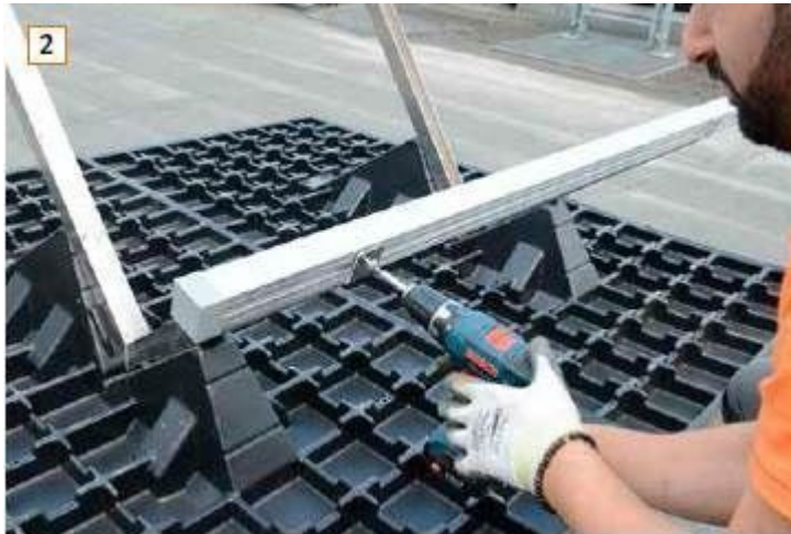
Verlegung SOLAR UK GD
