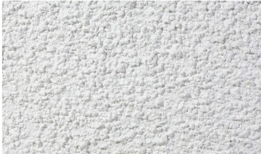
SYN_Fassadenputz grob gespritzt
